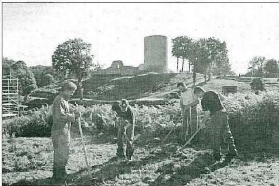
La préparation des fondations de la régie par sostra'palettes.
